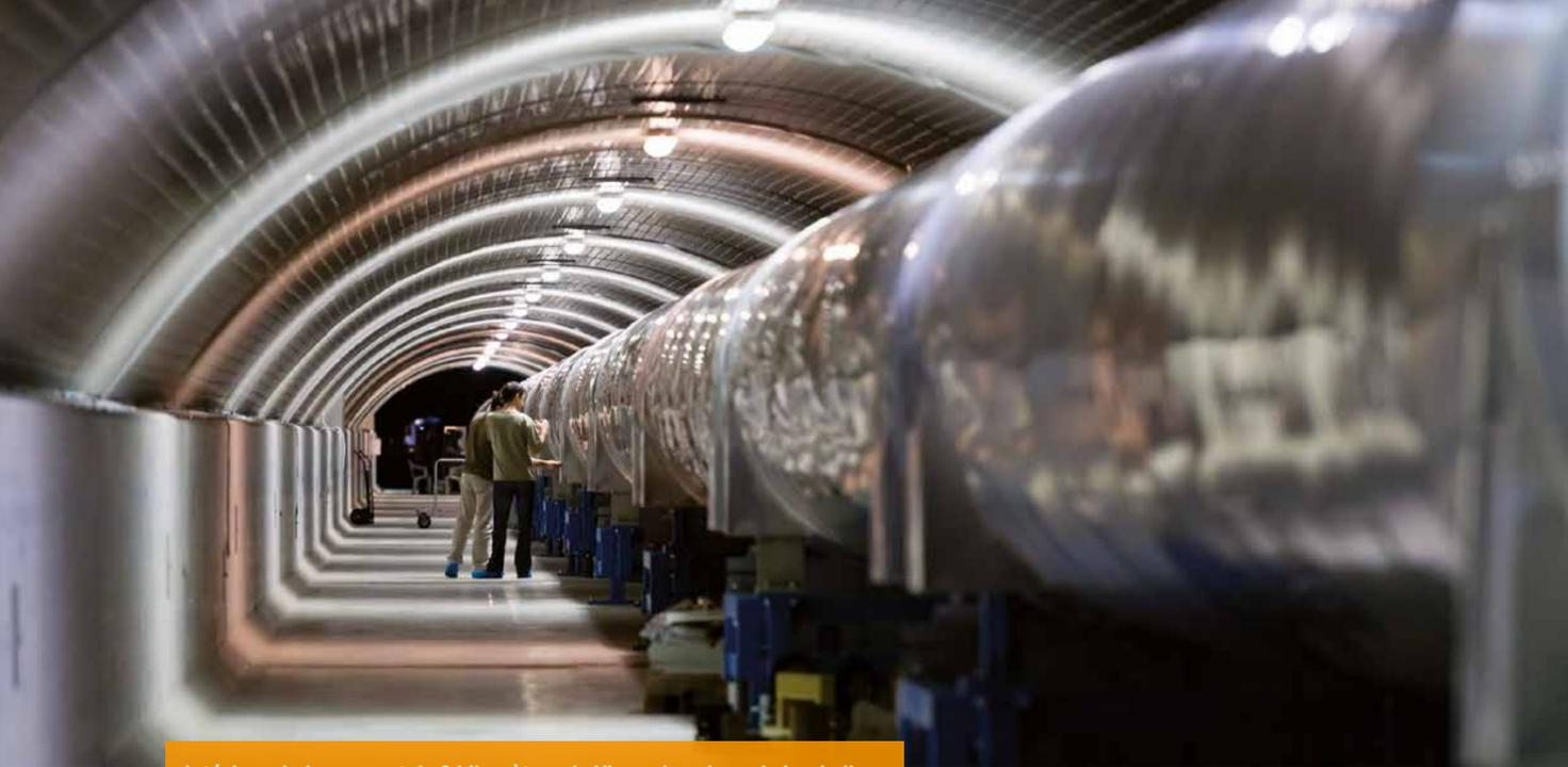
Intérieur du bras ouest de 3 kilomètres de Virgo, dans lequel circule l'un des deux faisceaux du laser infrarouge. Un autre bras perpendiculaire à celui-ci permet la propagation d'un second faisceau.
